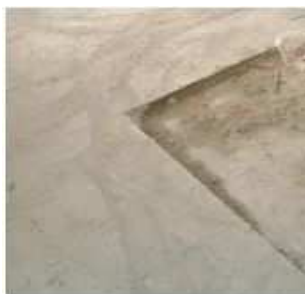
Réparation de sol
